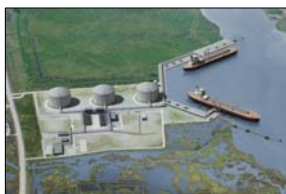
Cameron LNG project, US
